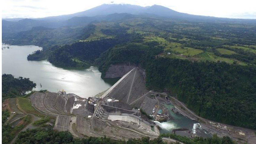
Imagen 16. Planta Hidroeléctrica Reventazón
