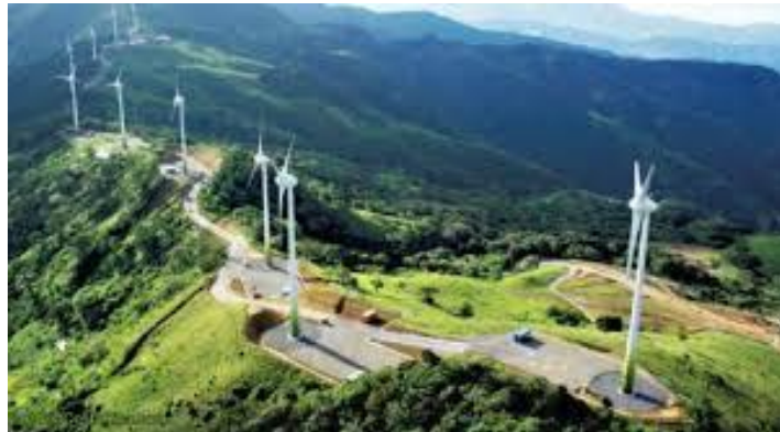
Imagen 3. Vista aérea del Proyecto Eólico Valle Central, ubicado en el cantón de Santa Ana
