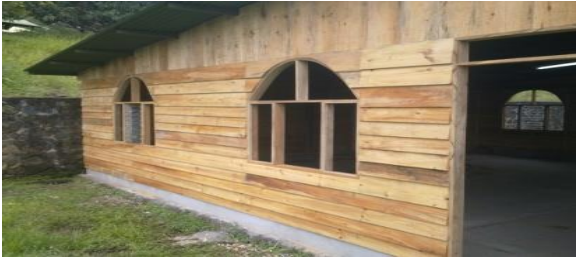
Primera aula construida por el departamento de mantenimiento.
