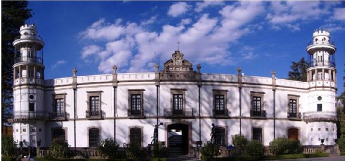
Universidad Autónoma Chapingo. Edificio emblemático de la institución.
