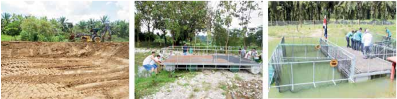
Foto 4. Construcción y puesta en posición de la plataforma flotante para sistemas de producción piscícola.
