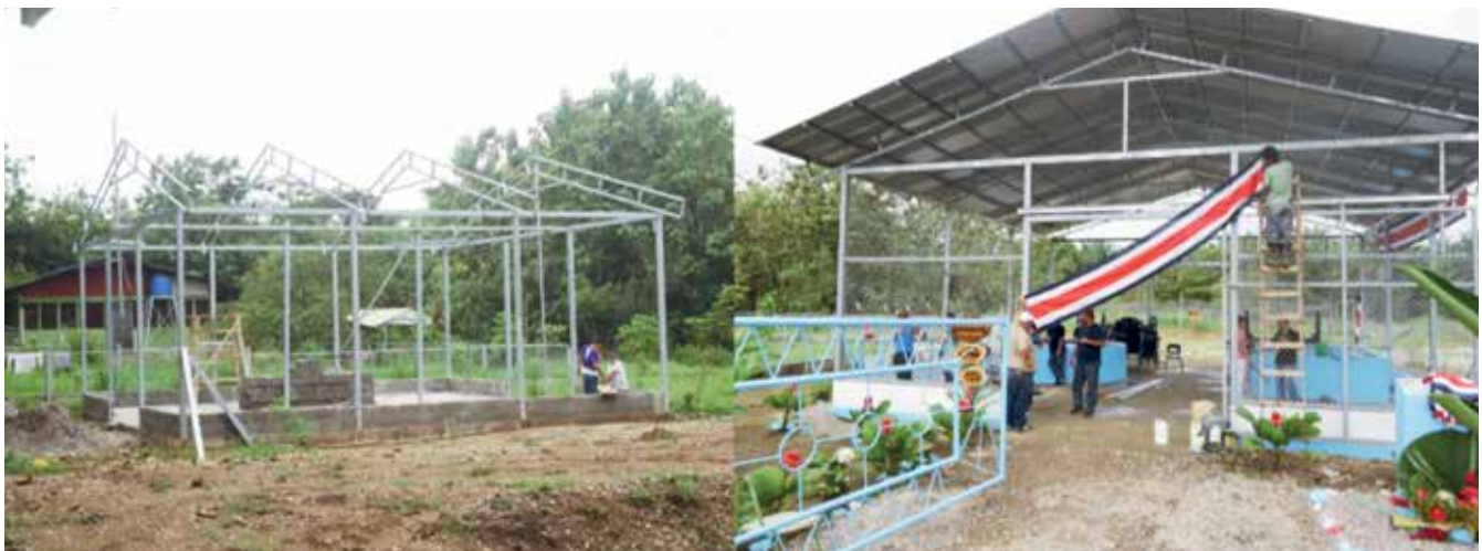
Foto 3. Construcción del laboratorio de inducción e incubación de peces de aguas continentales.
