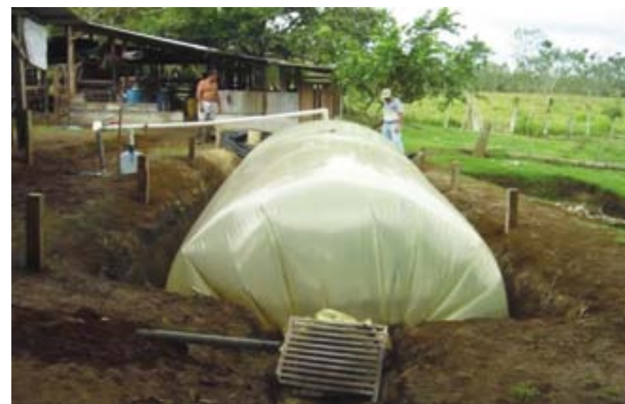
Figura 2. Biodigestor en bolsa doble de polietileno de bajo costo, modelo Taiwán, recién instalado (aún sin caseta, ni cerca periférica), operando en una finca familiar.
